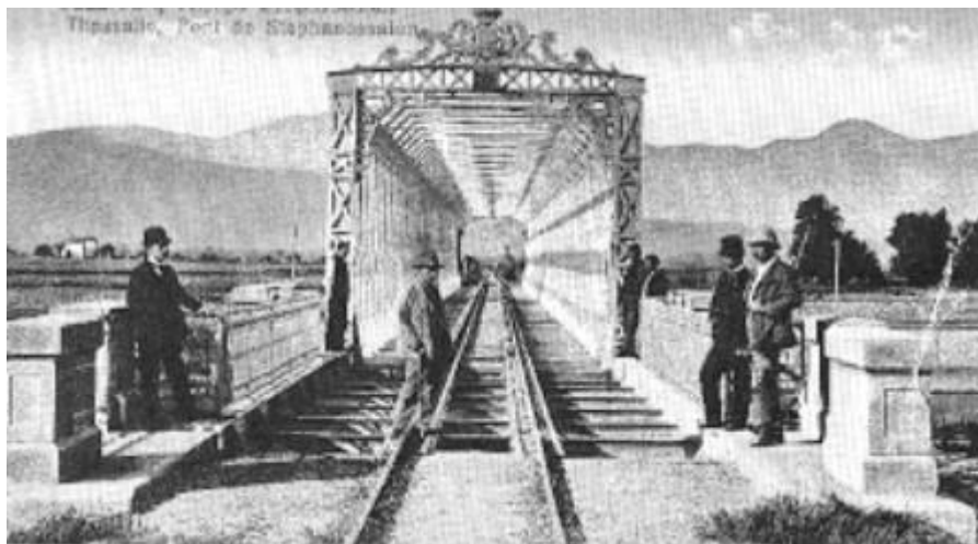
Η γέφυρα των Στεφανουσαίων, στον Πηνειό ποταμό
