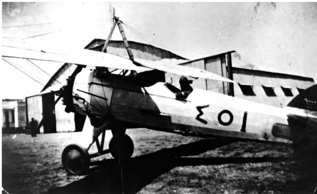
Φωτ. 32 - MoS 137 συναρμολογημένο από τα Συνεργεία Όρχου του Αεροπορικού Όρχου Θεσσαλονίκης, είτε από τμήματα αεροσκαφών που είχαν πάθει βλάβες, είτε από ανταλλακτικά.
