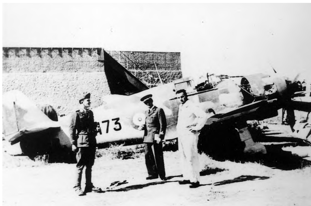
Φωτ. 43 - Φωτογραφία αντίστοιχης εγκατάστασης κατά τον Β΄ Π.Π..
