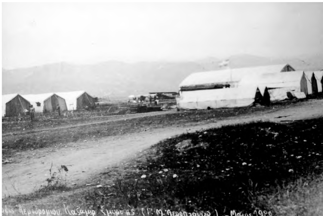
Φωτ. 24 - Αεροδρόμιο Καζαμίρ Σμύρνης, όπου και τα κεντρικά συνεργεία της Αεροπορίας κατά τη διάρκεια της Μικρασιατικής Εκστρατείας. Διακρίνονται τα γαλλικής προέλευσης μεγάλα πάνινα υπόστεγα Bessoneaux, που στέγαζαν τα αεροπλάνα.
